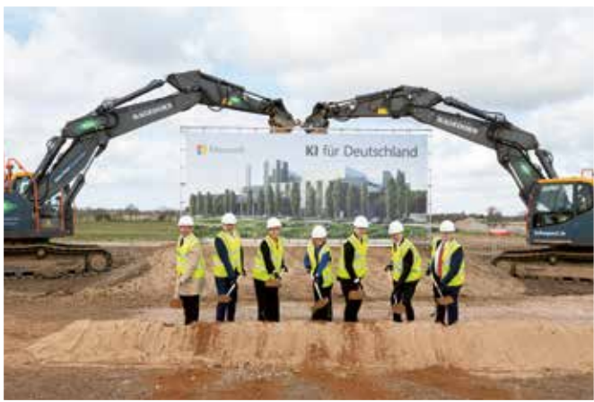
Spatenstich: Im März war Baubeginn für das Microsoft- Rechenzentrum im rheinischen Bergheim.
